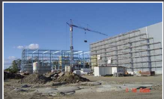
Koordination und Kontrolle der Bauleistungen durch BFI und seine Bauleiter
